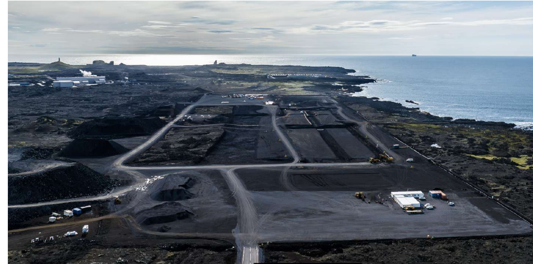
Framkvæmdir við Eldisgarð Samherja við Reykjanesvirkjun.
